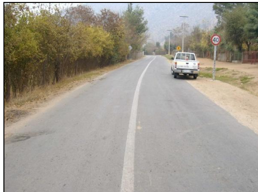
Camino con Lechada Asfáltica (Región Metropolitana)
